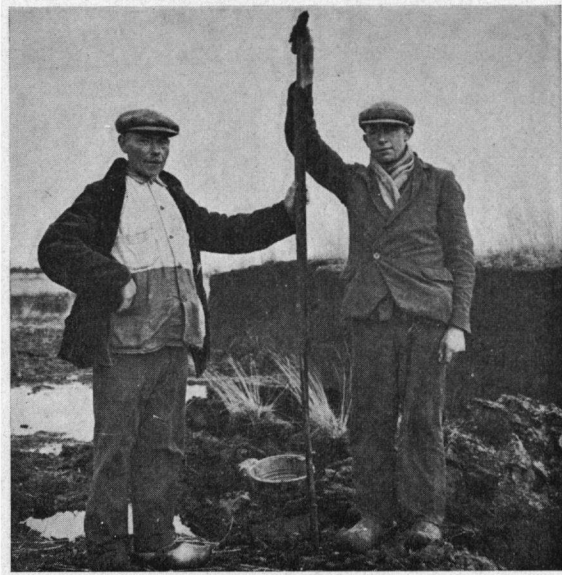
Foto 1. Veenboor in gebruik op de veenderij der Mij. Griendtsveen. Foto F. Florschütz.
