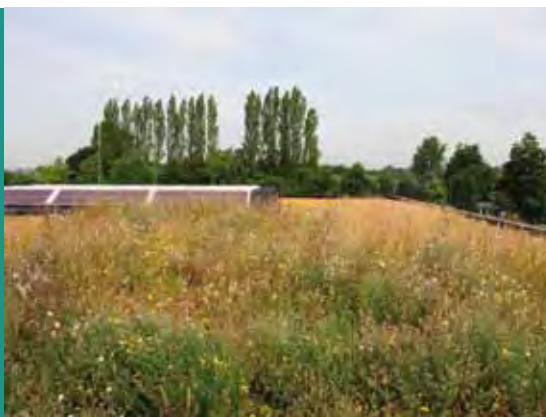
Foto 6.19 Een groendak op het gebouw van het NIOO-KNAW in Wageningen. Foto: Albert Vliegthart.
