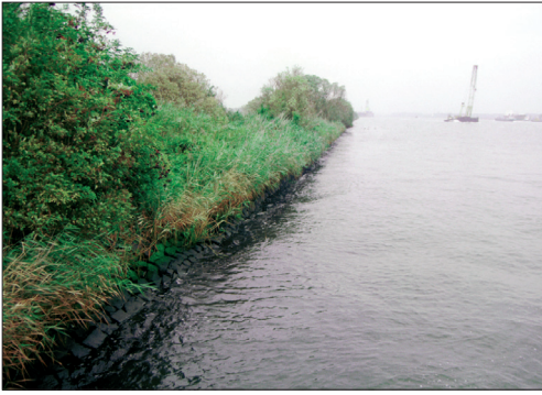
Figuur 3. Stortstenen bovenwateralud van het Noordzeekanaal ter hoogte van de Houthavens. Figure 3. Stony banks of the Noordzeekanaal near the Houthavens.
