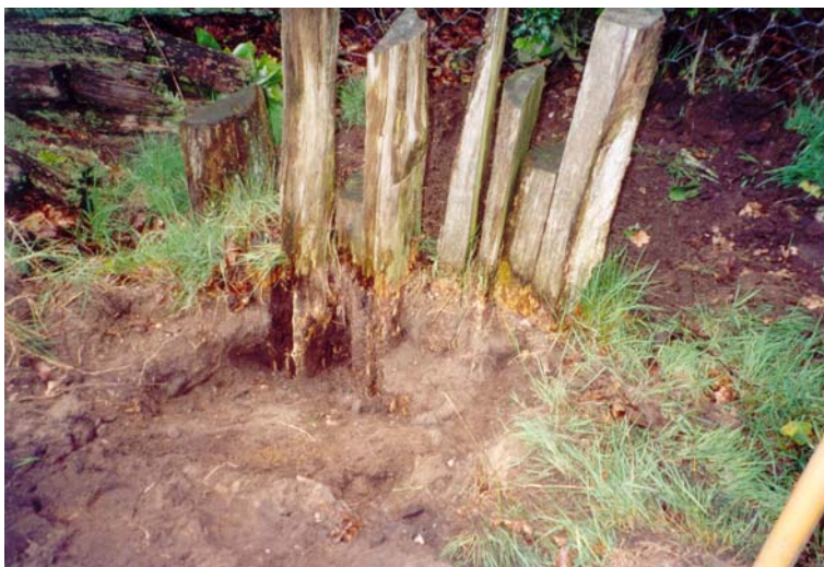
Broedstoof zoals deze is aangelegd in Vierhouten en Hoog Soeren. Foto P. Hendriks.
